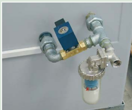
Dosatore di polifosfati ed elettrovalvola di by-pass
